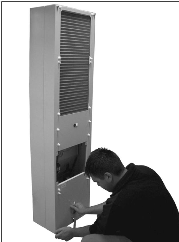
Obr. 70: Povolenie štyroch skrutiek krytu
