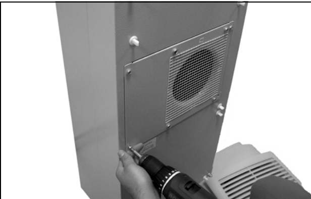
Obr. 63: Uvoľnenie štyroch skrutiek ventilátora vonkajšieho otvoru
