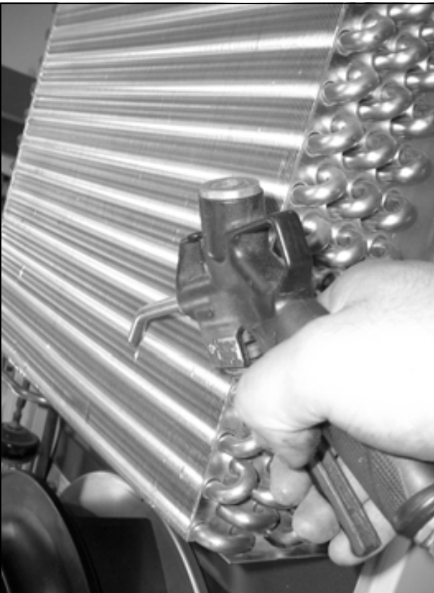
Obr. 75: Vyfúkanie telesa výmenníka tepla a priestoru kompresora stlačeným vzduchom (2)
