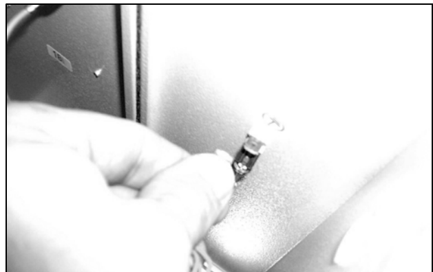
Obr. 69: Odpojenie zemniaceho kábla ventilátora (2)
