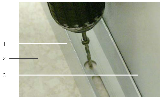
Рис. 8: Сверление крепежных отверстий
