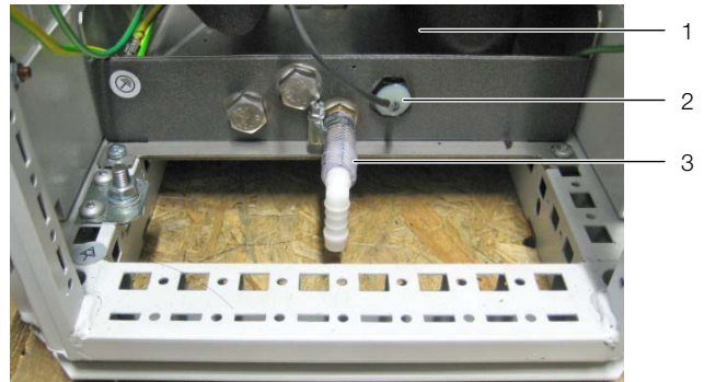
Рис. 52: Отвод конденсата
