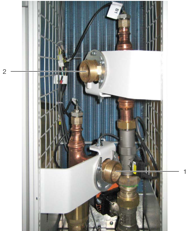
Рис. 46: Подключение холодной воды
