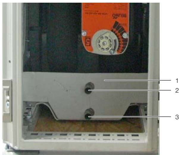
Fig. 51: Condensate discharge
