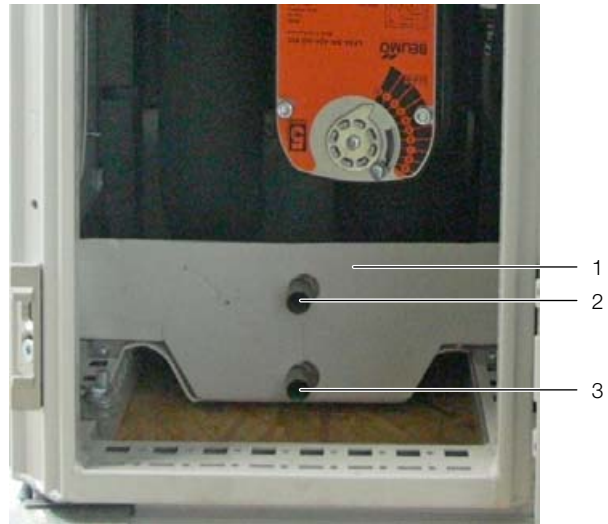
Fig. 73: Condensate discharge
