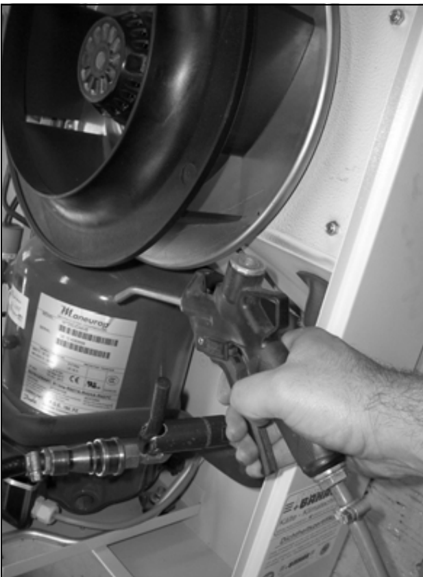
Bild 52: Rengör värmeväxlarpaketet och kompressorum med tryckluft (2)
