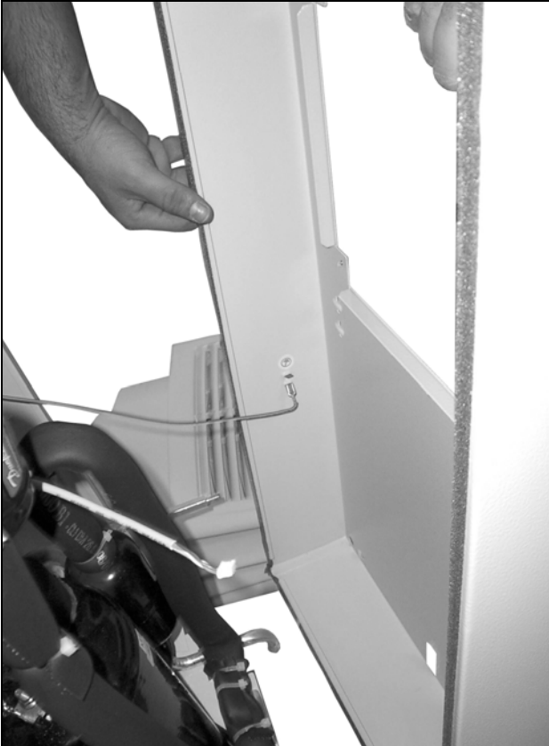
Bild 72: Dra ut jordkabeln (1)
