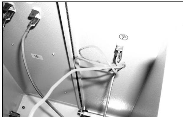
Rys. 68: Rozłączanie kabla uziemiającego wentylatora (1)
