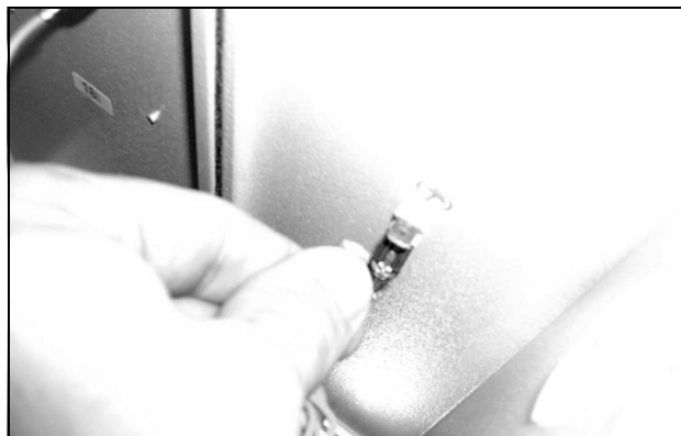
Rys. 69: Rozłączanie kabla uziemiającego wentylatora (2)
