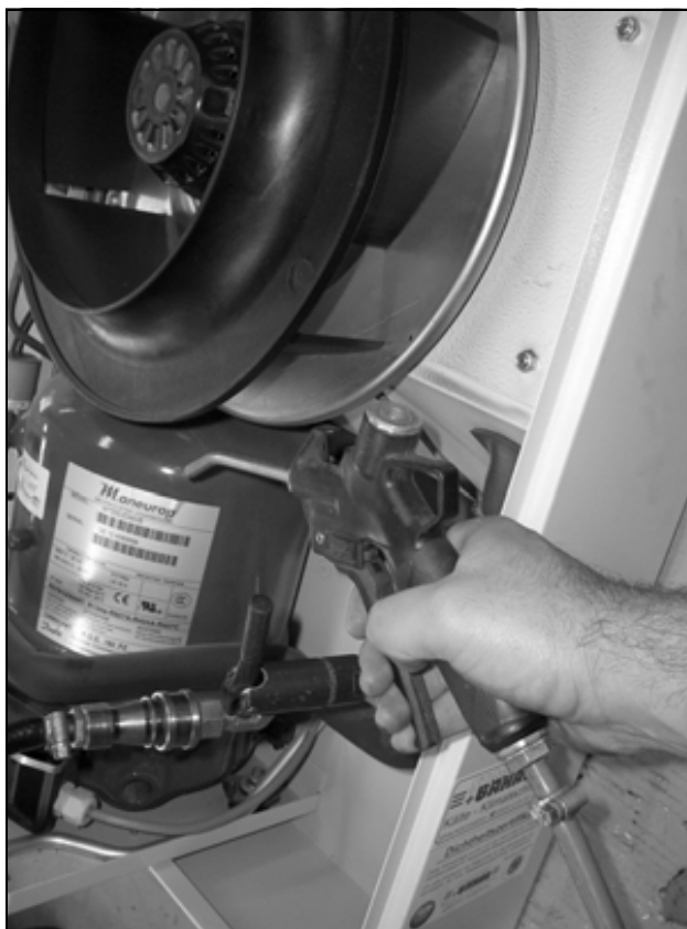
Rys. 76: Przedmuchiwanie sprężonym powietrzem rejestru wymiany ciepła i pomieszczenia kompresora (3)
