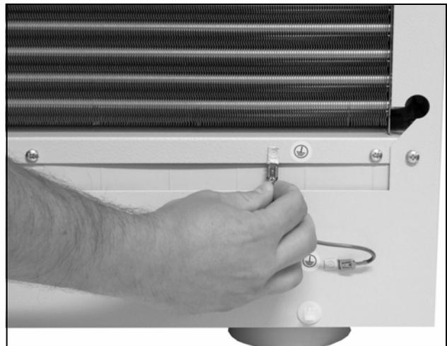
Imagen 25: Desconectar el cable de puesta a tierra
