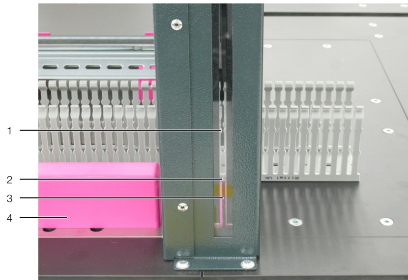
Abb. 13: Ausrichten eines Kabelkanals
