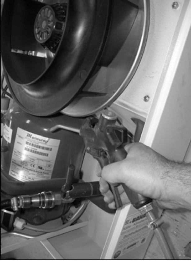
Şek. 76: Isı eşanjörü devresi ve kompresör odasını basınçlı hava ile temizleyin (3)
