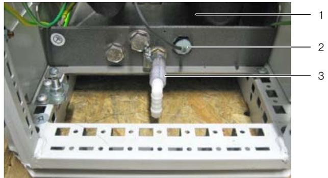
Imagen 52: Evacuación del agua de condensación
