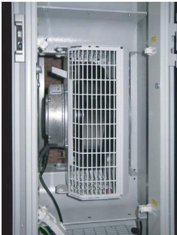
Imagen 33: Módulo de ventiladores girado – ejecución LCP Inline flush
