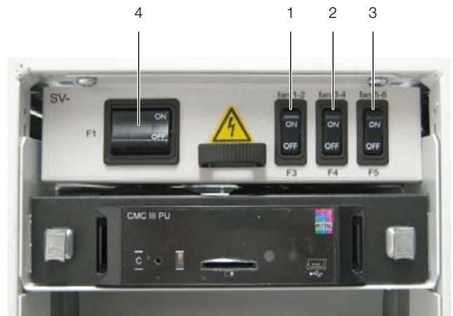
Imagen 13: Caja de fusibles con interruptor principal
