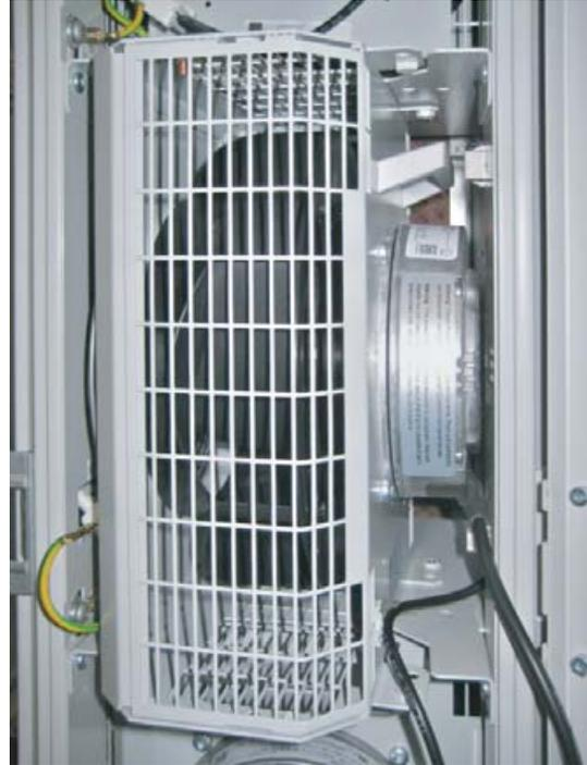
Imagen 31: Módulo de ventiladores girado – ejecución LCP Inline y LCP Rack
