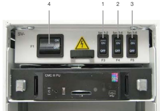
Imagen 29: Caja de fusibles con interruptor principal
