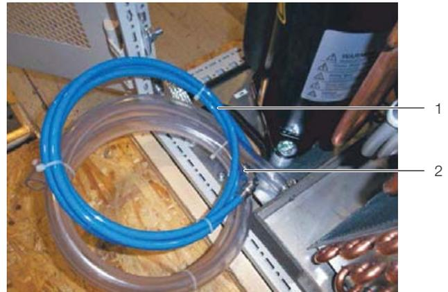
Imagen 50: Tubo de conexión con pieza de conexión rosca exterior de 1/8"
