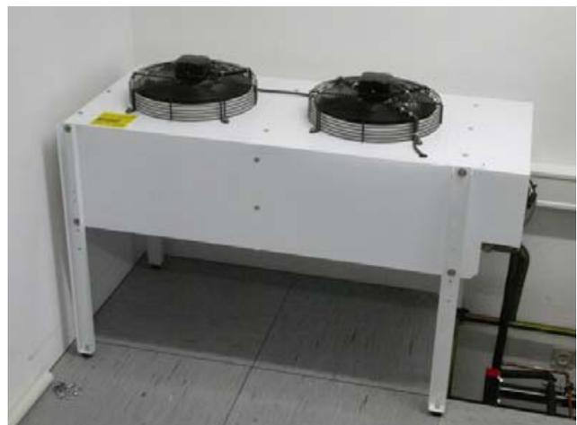
Imagen 9: Condensador externo (3311.360)
