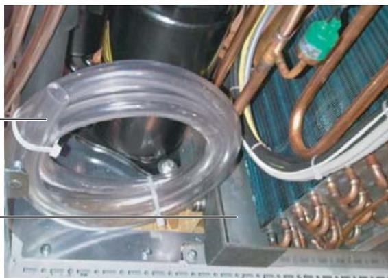
Imagen 27: Evacuación del agua de condensación
