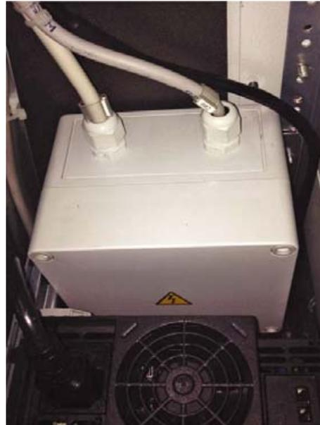
Imagen 54: Caja adicional para los fusibles térmicos de los calefactores eléctricos
