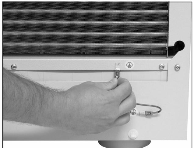
Fig. 25: Desencaixar o cabo de aterramento
