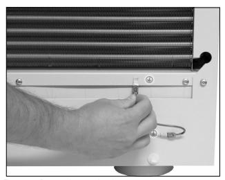
Fig. 25: Desencaixar o cabo de aterramento
