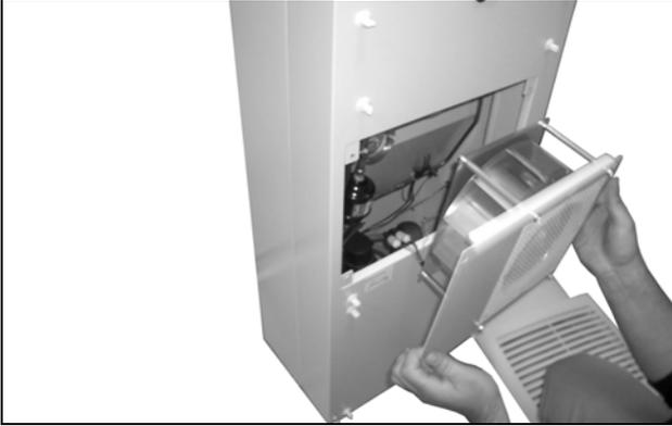
Imagen 64: Desmontar el ventilador del circuito exterior
