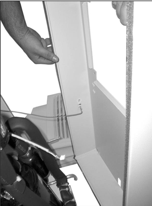
Imagen 72: Desconectar el cable de puesta a tierra (1)
