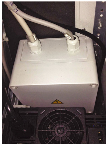
Abb. 49: Zusätzliche Box für die Thermosicherungen der elektrischen Heizer
