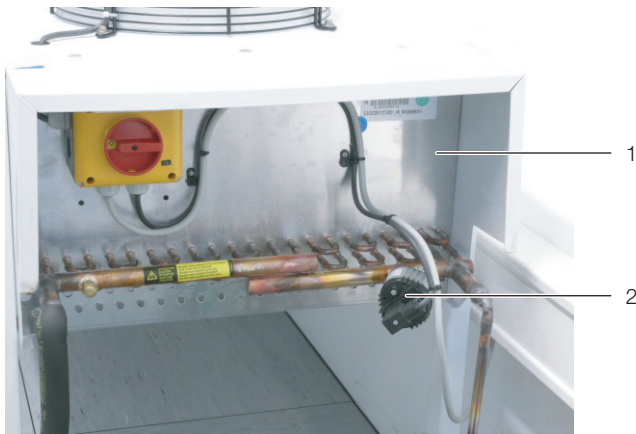
Abb. 25: Druckschalter am Verflüssiger
