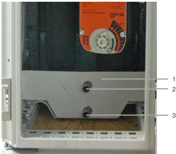
Рис. 73: Отвод конденсата
