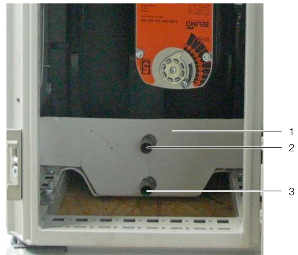
Рис. 51: Отвод конденсата
