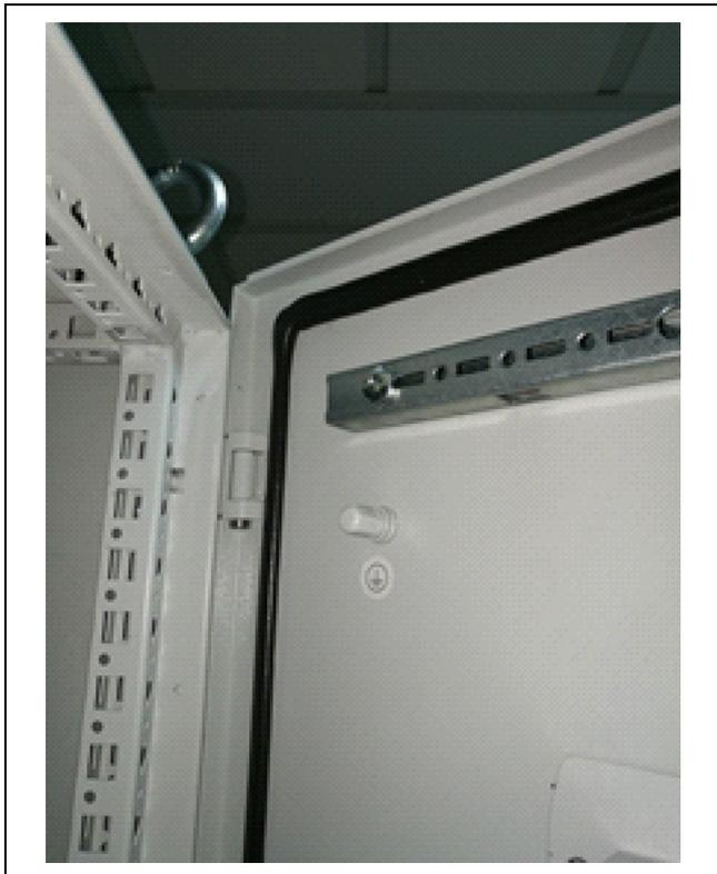
Fig. 11 : points de raccordement pour câbles de mise à la masse
