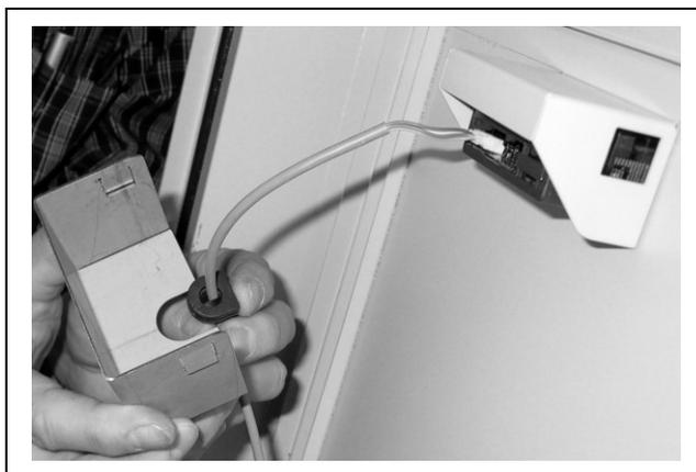
Fig. 14 : Insérer le joint passe-câble
