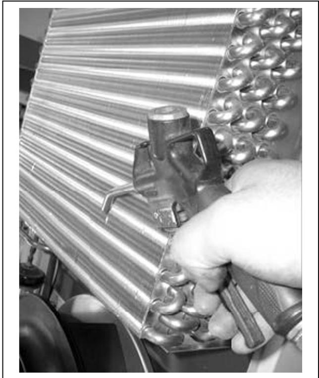
Fig. 30: Wärmetauschregister und Kompressorraum mit Druckluft ausblasen
