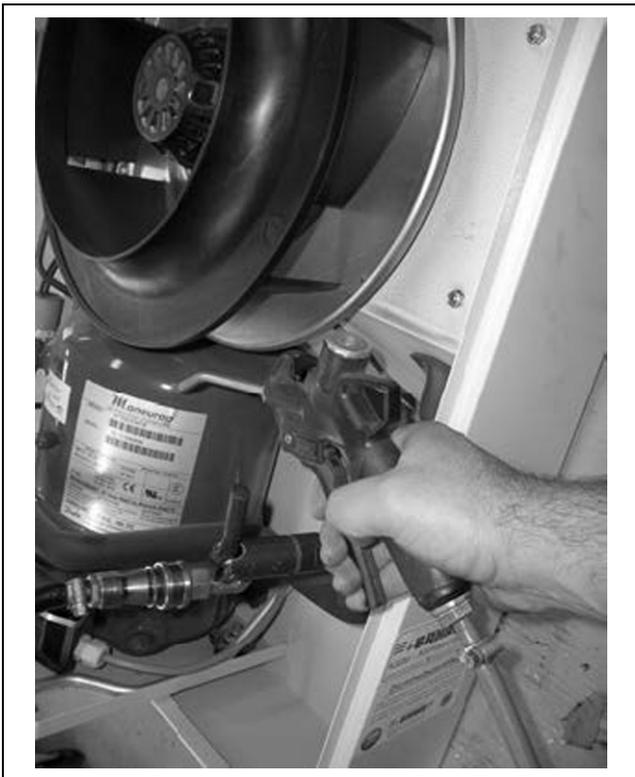
Fig. 31: Wärmetauschregister und Kompressorraum mit Druckluft ausblasen
