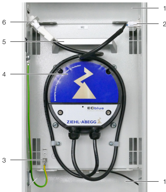
Fig. 6: Fan module in fan tray
