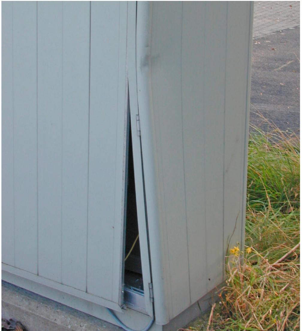
Abbildung 1: Verformtes Gehäuse nach Kräfteinwirkungen
