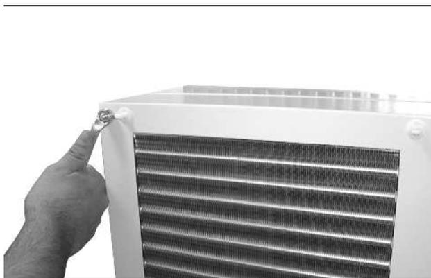
Fig. 48 : Démontez le capot (dévisser les quatre écrous)
