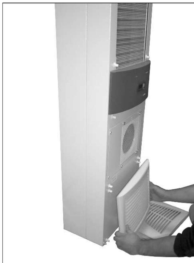
Fig. 62 : Retirer la grille à lamelles inférieure (2)
