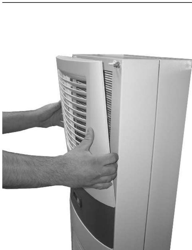
Fig. 39 : Retirer la grille à lamelles supérieure
