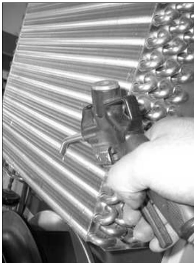
Fig. 55 : Nettoyer l'unité d'échange thermique et l'espace compresseur à l'air comprimé (1)
