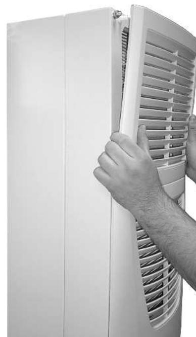
Fig. 59 : Retirer la grille à lamelles supérieure (2)
