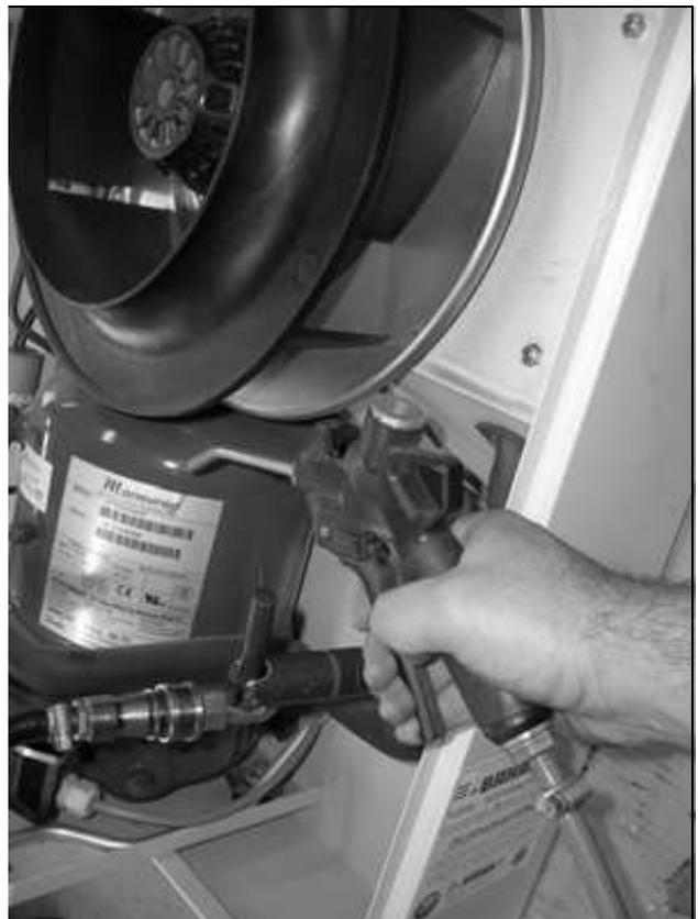
Fig. 80 : Nettoyer l'unité d'échange thermique et l'espace compresseur à l'air comprimé (3)
