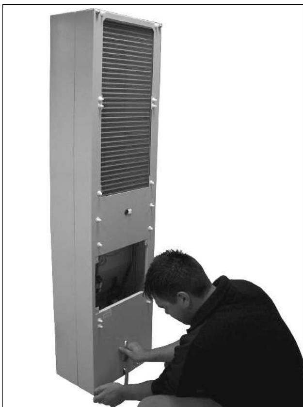
Fig. 74 : Dévisser les 4 écrous du capot
