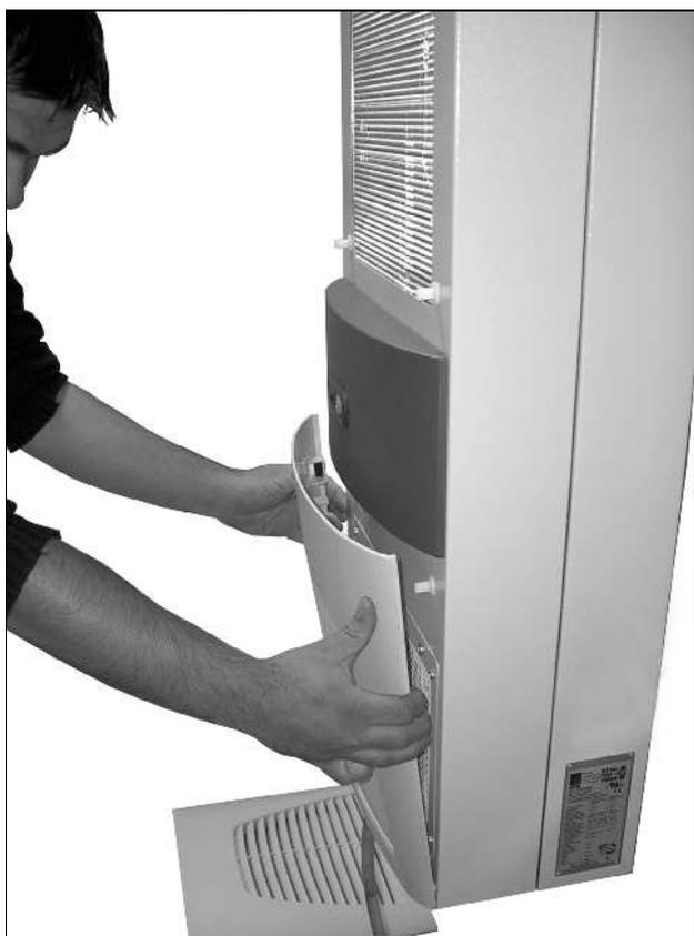
Fig. 40 : Retirer la grille à lamelles inférieure
