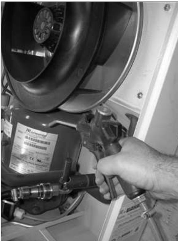
Fig. 56 : Nettoyer l'unité d'échange thermique et l'espace compresseur à l'air comprimé (2)
