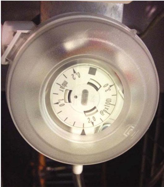
Abb. 62: Einstellschraube am Differenzdrucksensor
