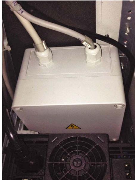
Abb. 57: Zusätzliche Box für die Thermosicherungen der elektrischen Heizer
