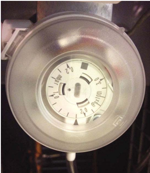
Abb. 60: Einstellschraube am Differenzdrucksensor
