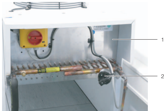
Abb. 27: Druckschalter am Verflüssiger
