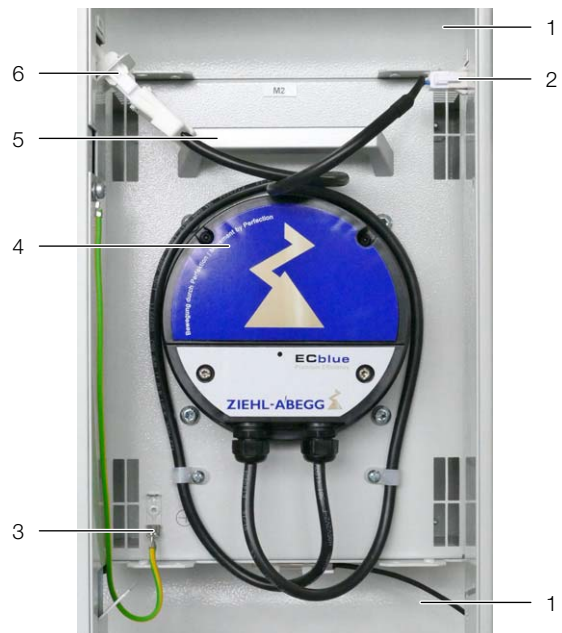
Abb. 39: Lüftermodul im Lüftereinschub
