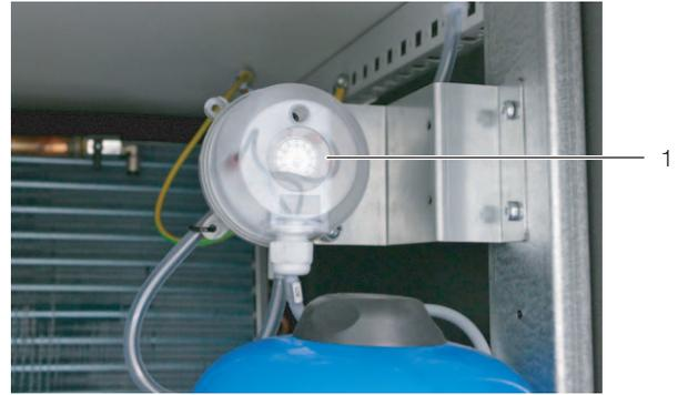
Abb. 65: Einstellschraube am Differenzdrucksensor
