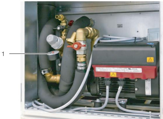
Abb. 44: Manometer im Wasserkreislauf
