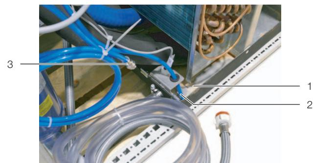
Abb. 64: Anschlüsse der Kondensatpumpe
