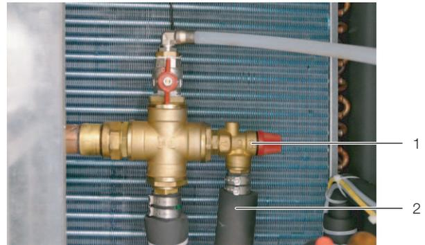
Abb. 24: Sicherheitsventil auf der Rückseite
