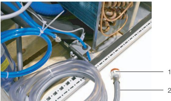
Abb. 55: Anschlusschlauch mit Anschlussstück  $\frac{3}{4}$ " Außengewinde
