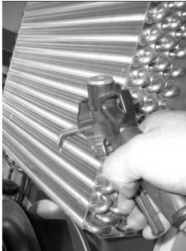
Fig. 79: Soffiare aria compressa sui tubi dello scambiatore di calore e nel vano compressore (2)
