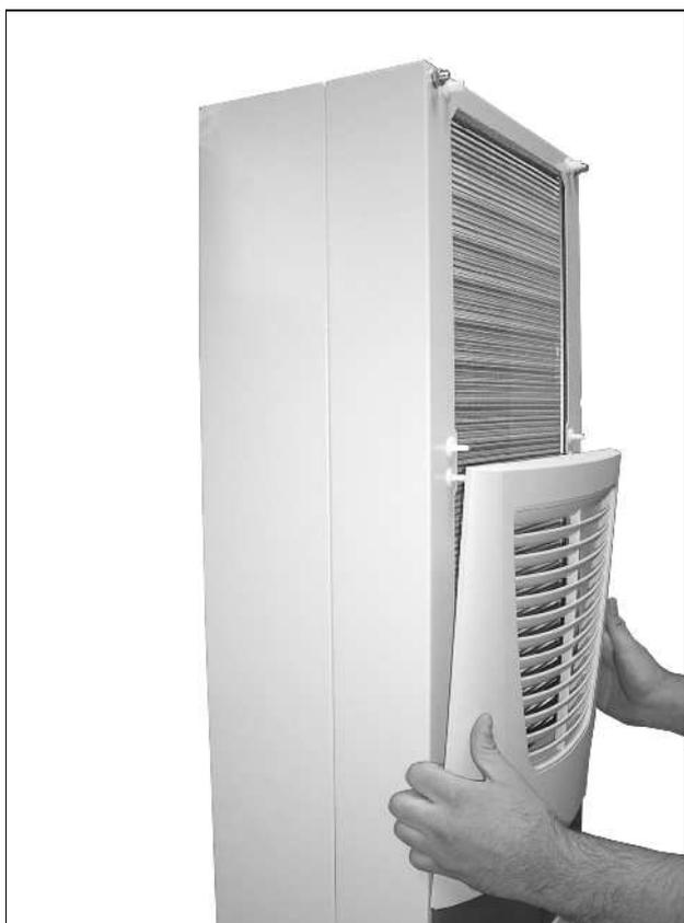
Fig. 60: Asportare la griglia di aerazione superiore (3)
