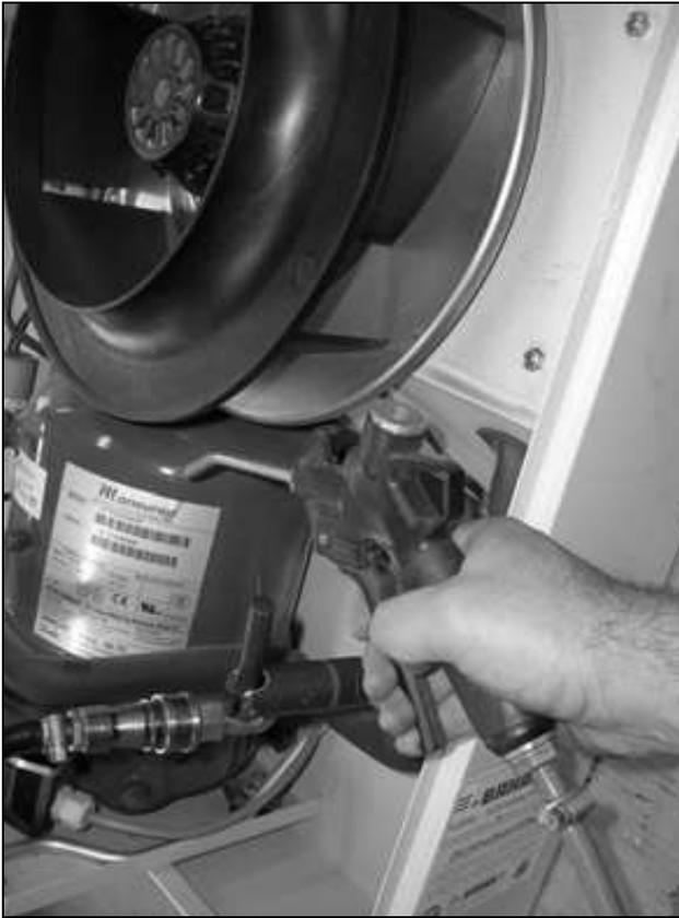
Fig. 56: Soffiare aria compressa sui tubi dello scambiatore di calore e nel vano compressore (2)
