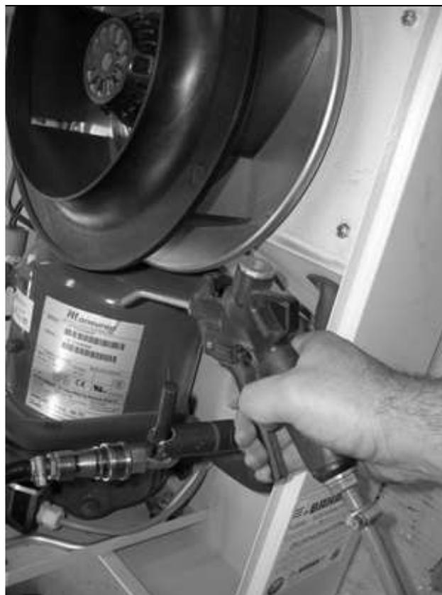
Fig. 80: Soffiare aria compressa sui tubi dello scambiatore di calore e nel vano compressore (3)
