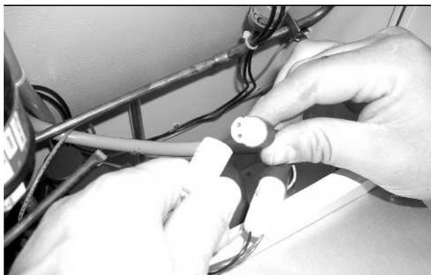
Fig. 71: Staccare i connettori del ventilatore (3)
