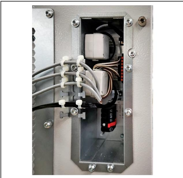
Abb. 33: Montagepunkt der Ferritkerne bei SK 3186330, SK 3187330, SK 3188340, SK 3189340
