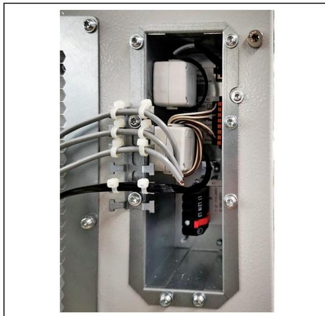
Fig. 33 : point de montage du noyau en ferrite pour climatiseurs SK 3186330, SK 3187330, SK 3188340, SK 3189340
