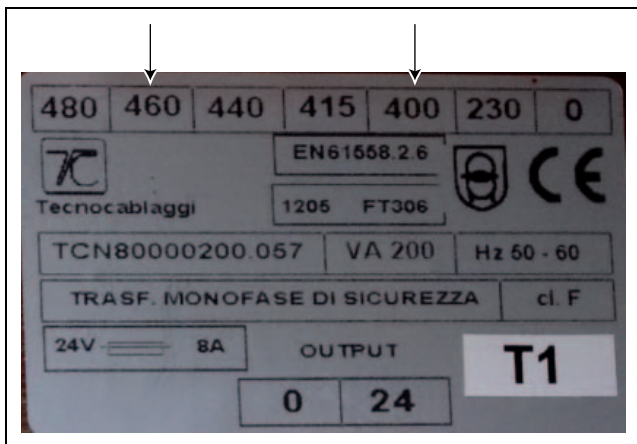
Fig. 9: Collegamento del trasformatore
