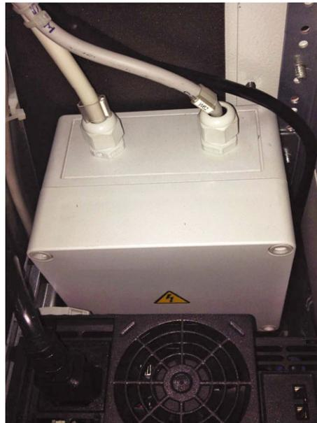
Fig. 57 : boîte supplémentaire pour les fusibles thermiques des résistances chauffantes
