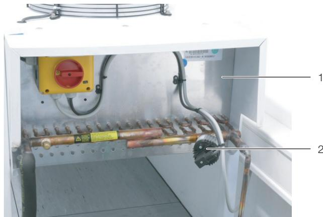
Fig. 27 : pressostat sur condenseur
