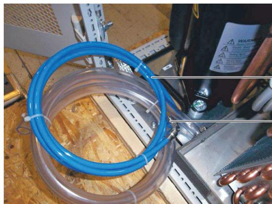
Fig. 53 : tuyau de raccordement avec raccord filetage extérieur 1/8"
