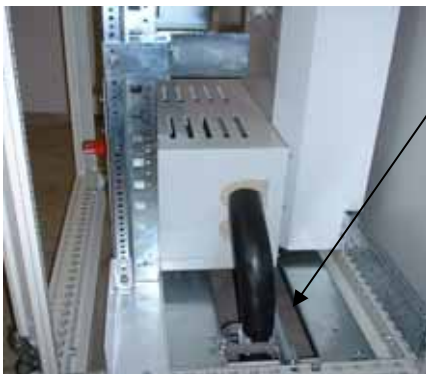
Разгрузка от натяжения (9) кабеля
