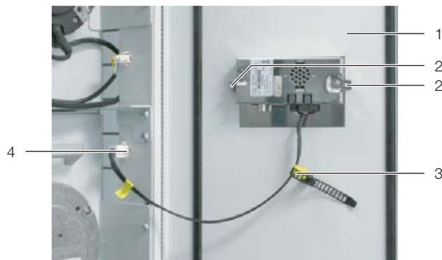
Рис. 31: Крепление графического дисплея
