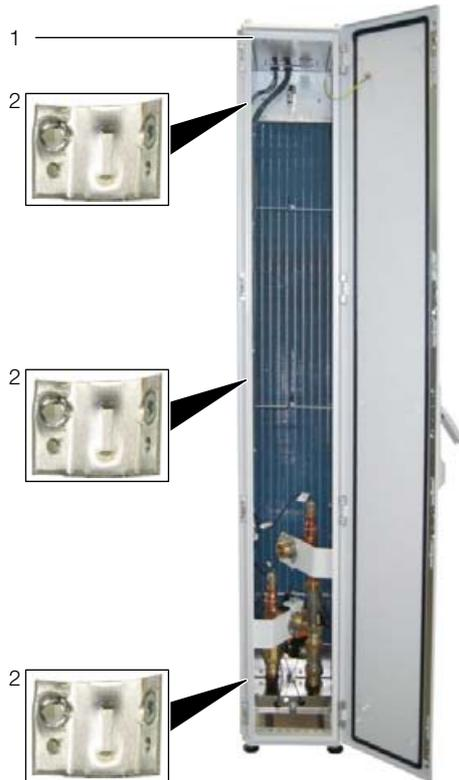
Рис. 24: LCP Rack – задняя сторона
