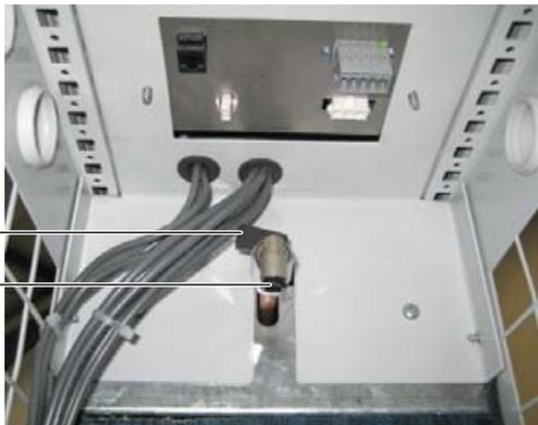
Рис. 42: Удаление воздуха из теплообменника
