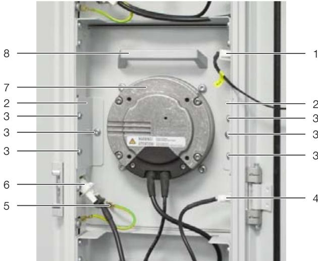
Рис. 27: Вентиляторный модуль в модульном отсеке
