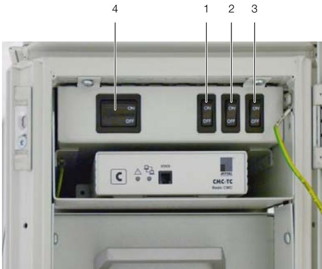
Рис. 11: Блок предохранителей
