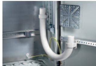
**Kabelschlauch und Kabelschlauchhalter**
