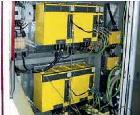
Abb. 38: Einhaltung von Mindestabständen bei mehrzeiligen Antriebsverbänden
