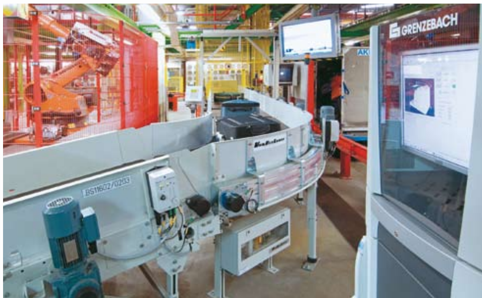
Durch ein Sichtfenster im Rittal PC-Schrank lassen sich im oberen Bereich des Schrankes die Prozessdaten zur Gepäckvermessung über einen Monitor komfortabel überwachen.
