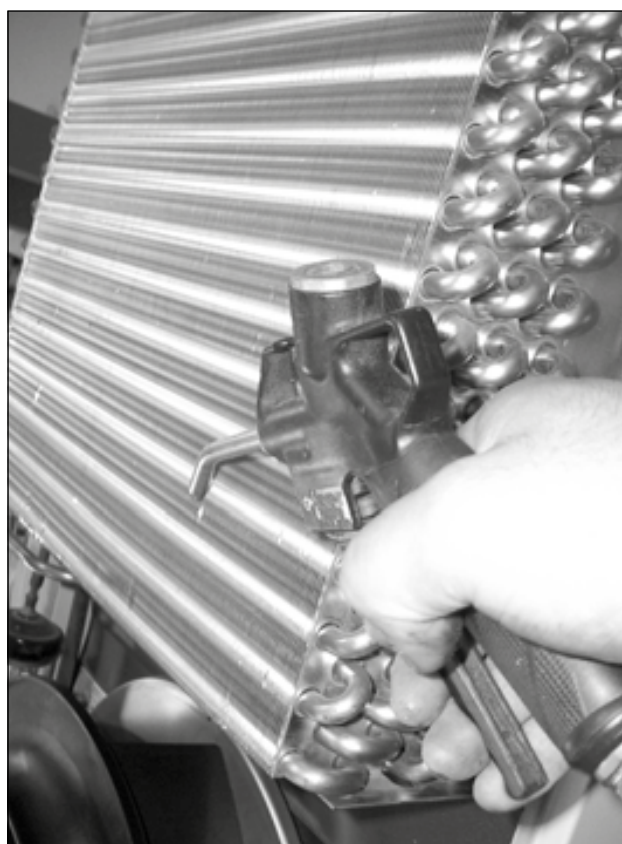
56. ábra: Hőcserélő csőhígyó és kompresszortér kifűvátása sűrített levegővel (1)
