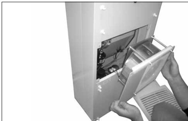
69. ábra: Vegye le a külső keringetőventilátort
