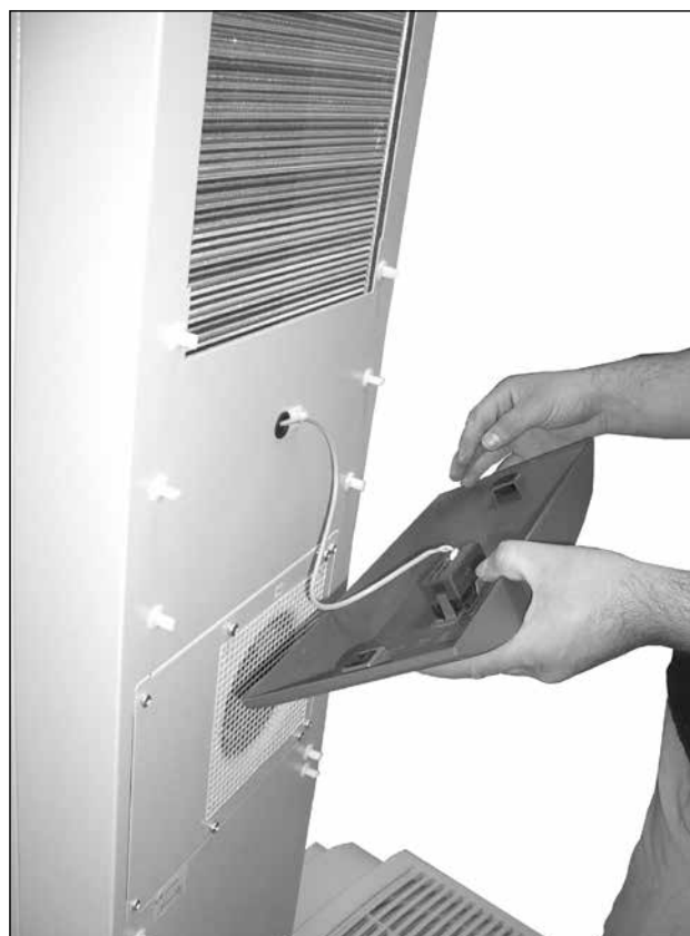
64. ábra: A közpanel eltávolítása
