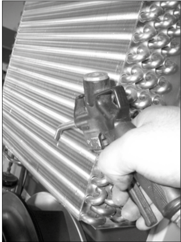
80. ábra: Hőcserélő csőkégyő és kompresszortér kifűvatása sűrített levegővel (2)
