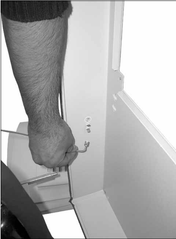
78. ábra: A földelőkábel kihúzása (2)
