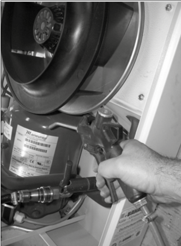
57. ábra: Hőcserélő csőkégyő és kompresszortér kifűvátása sűrített levegővel (2)
