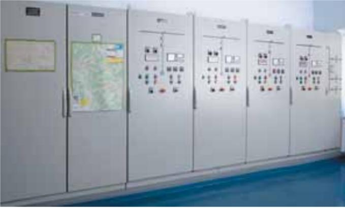
La potenza dissipata totale del quadro si ricava sommando le potenze dissipate di tutti i circuiti. Tuttavia è importante tenere in considerazione che la corrente totale del carico è limitata alla corrente nominale del quadro ( $I_{nA}$ ).
