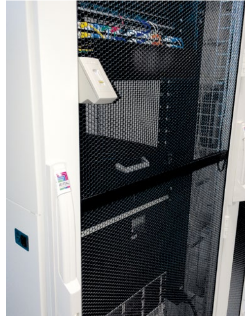
Fingerscanner können für Einzelschränke oder ganze Schrankreihen vorgesehen werden.
