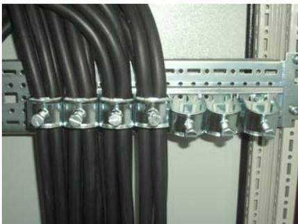
Von den PDM-Anschlusskabel können immer 4 Stück unter eine Kabelschelle (12) geklemmt werden. Das Kabel wird durch das Bodenblech im Doppelboden zu den Racks verlegt
