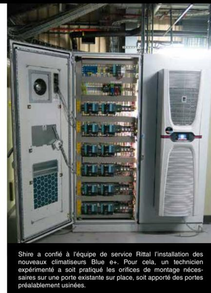
Shire a confié à l'équipe de service Rittal l'installation des nouveaux climatiseurs Blue e+. Pour cela, un technicien expérimenté a soit pratiqué les orifices de montage nécessaires sur une porte existante sur place, soit apporté des portes préalablement usinées.
