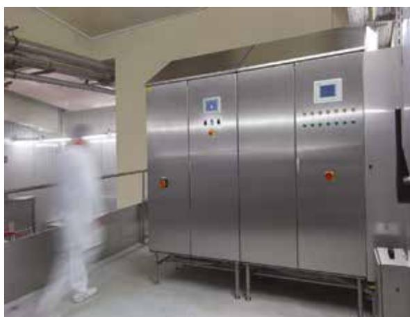
Figura 3: Batteria di armadi Rittal TS 8 in acciaio inox per differenti applicazioni nell'industria alimentare.
