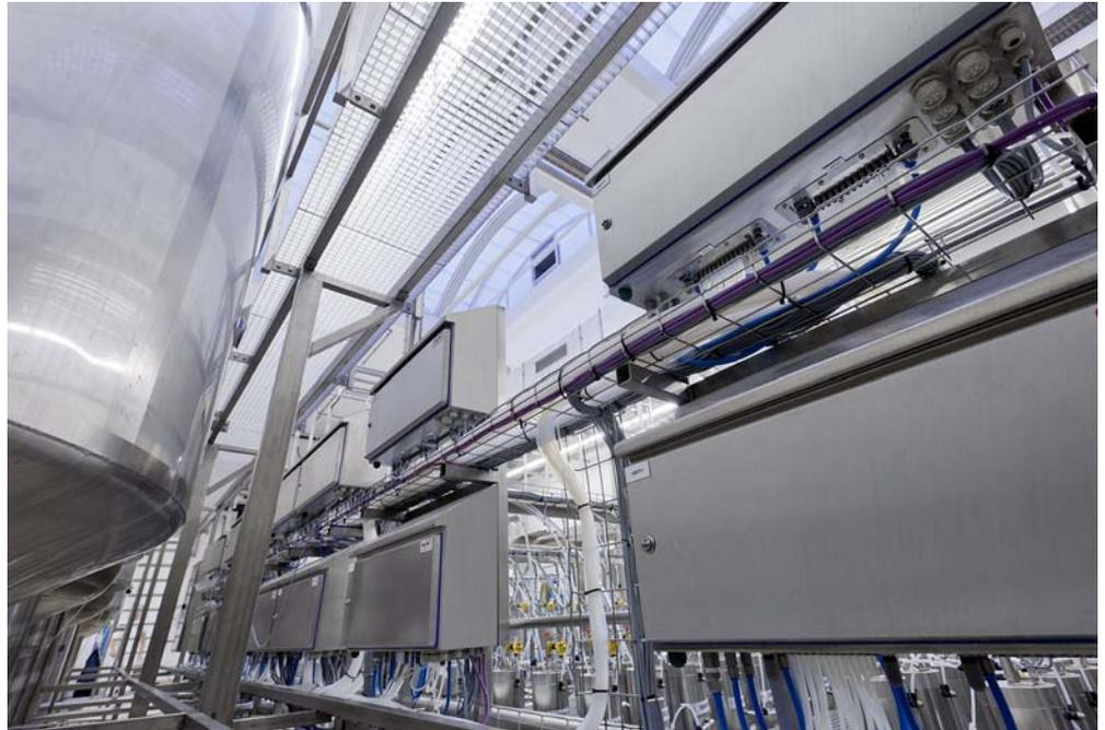
Abbildung 2: Automatisierungstechnik bei FrieslandCampina sicher geschützt in Hygienic Design Gehäusen von Rittal
