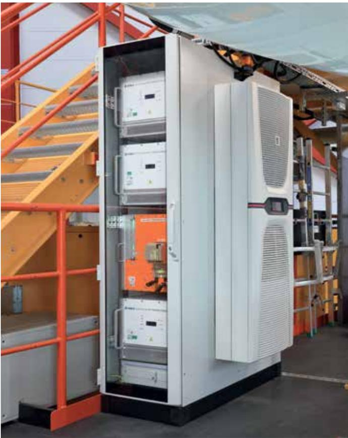
冰冷马拉松 Blue e+ 系列中的冷却装置持续运行，防止硬件过热。
