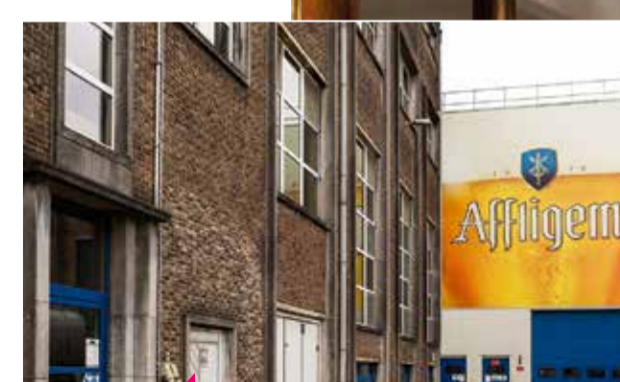
Bij Alken-Maes groeide de nood aan een uitgebreide (data) infrastructuur. De uitdaging hierin bestond voornamelijk uit het vinden van een goede locatie, in de verschillende brouwerijen, om een serverlokaal op te richten.
