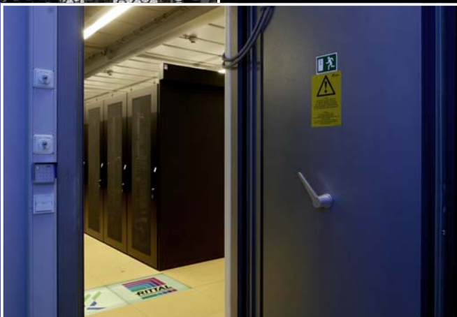
Sicherheitstür des ECB-S zertifizierten Hochverfügbar- keitsraumes
