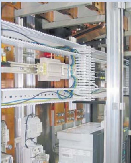
Низковольтное энергоснабжение с помощью Rittal Maxi-PLS.
