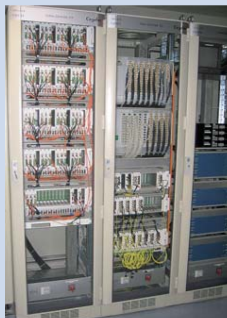
Распределительные шкафы Rittal в диспетчерской для видеонаблюдения.
