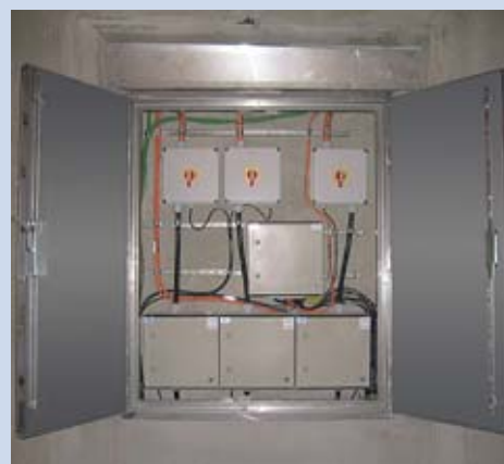
Сохранность электронного оборудования благодаря использованию пластиковых шкафов Rittal KS. Наружные двери выполнены из нержавеющей стали с классом противопожарной защиты E90.
