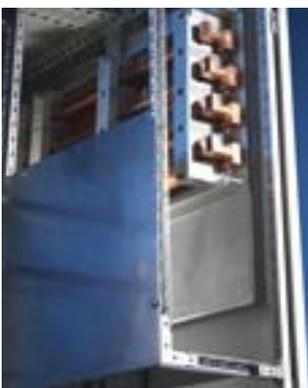
Профиль Mini-TS – это миниатюрный вариант элементов TS. Он обеспечивает расширение спектра монтажа для небольших и средних нагрузок.
