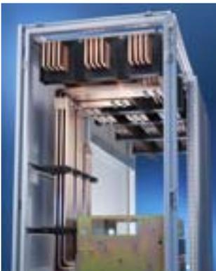
Конструкция системы аналогична Maxi-PLS, со стандартными плоскими медными шинами.
