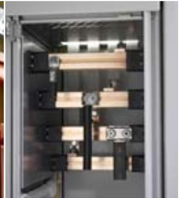
. . . подсоединять круглые провода, гибкие медные шины, а также соединительные уголки и соединительные комплекты.
