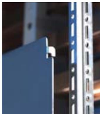
Профиль Mini-TS, с **трехсторонней монтажной поверхностью**, позволяет использовать все преимущества быстрого монтажа элементов шкафа TS 8.
