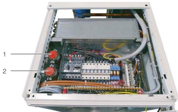
Рис. 24: Точки подключения сверху на агрегате.
