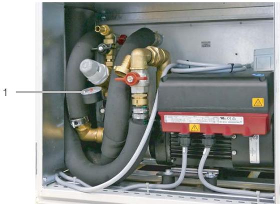
Рис. 48: Манометр в водяном контуре
