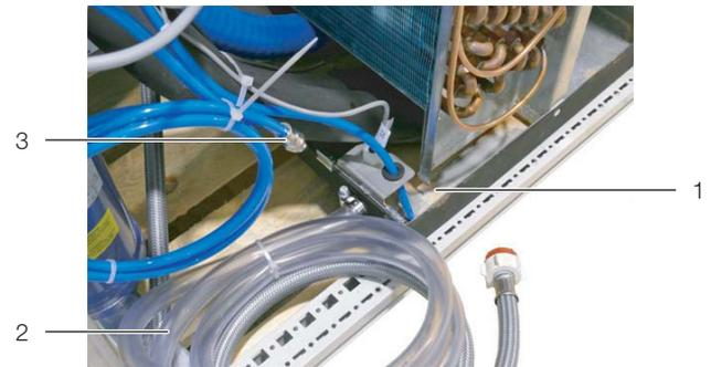
Рис. 26: Отвод конденсата
