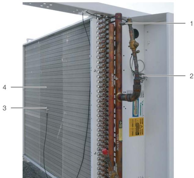
Рис. 32: Подключение датчиков
