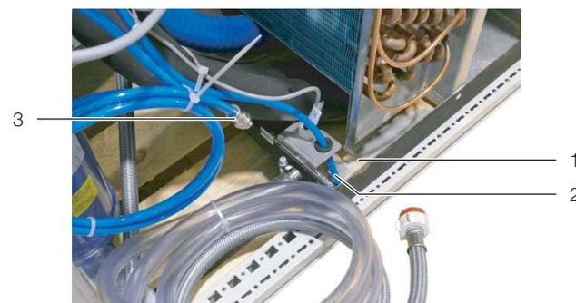
Рис. 63: Подключения насоса конденсата
