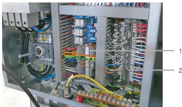
Рис. 34: Блоки клемм X1A и X2A на распределительном щитке
