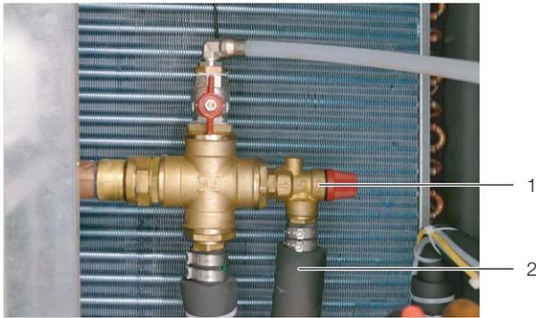
Рис. 27: Предохранительный клапан с задней стороны
