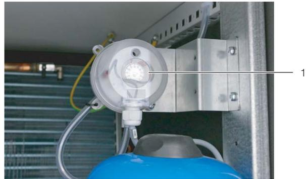
Рис. 64: Винт настройки датчика перепада давления
