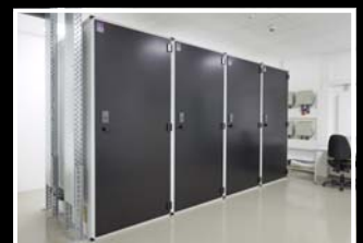
Verkettung von 4 Micro Data Center für den Schutz von 4 Server-Racks
